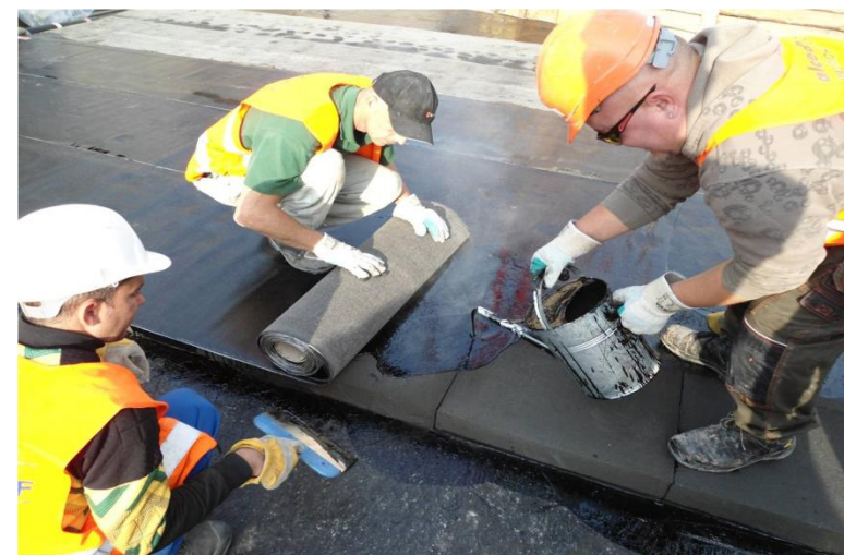
AP CELOPLOŠNĚ NATAVENÝ NA PĚNOSKLE - SPOLUPŮSOBÍ
