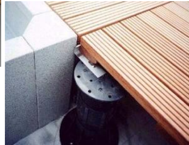
ROŠT Z LAMEL NA REKTIFIKAČNÍCH PODLOŽKÁCH
