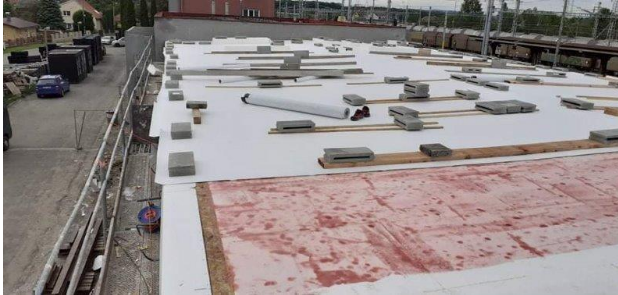
NALEPENÍ HYDROIZOLAČNÍ FOLIE
