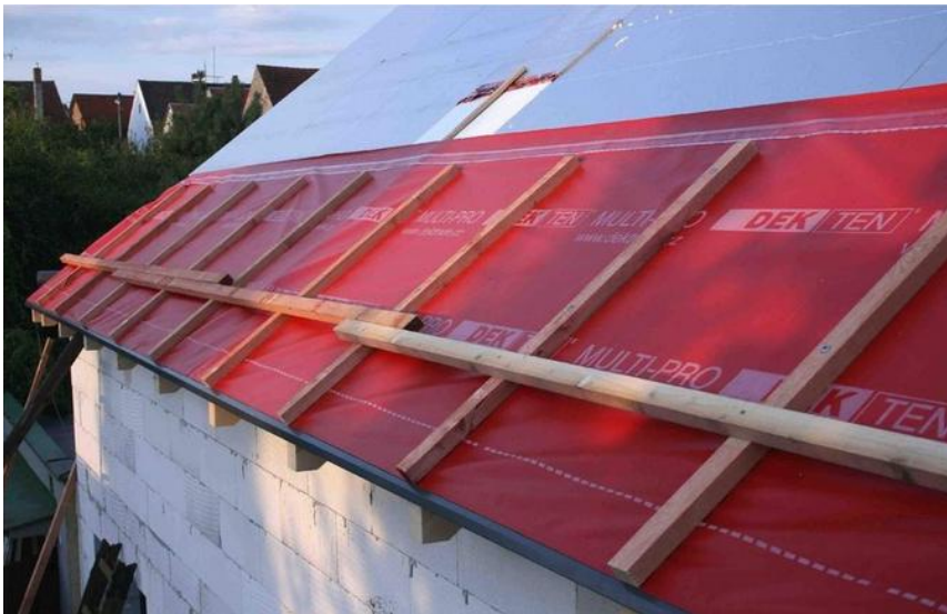
DHV UKONČIT NA OKAPNÍM PLECHU A VIDITELNĚ – SIGNÁLNÍ FUNKCE
