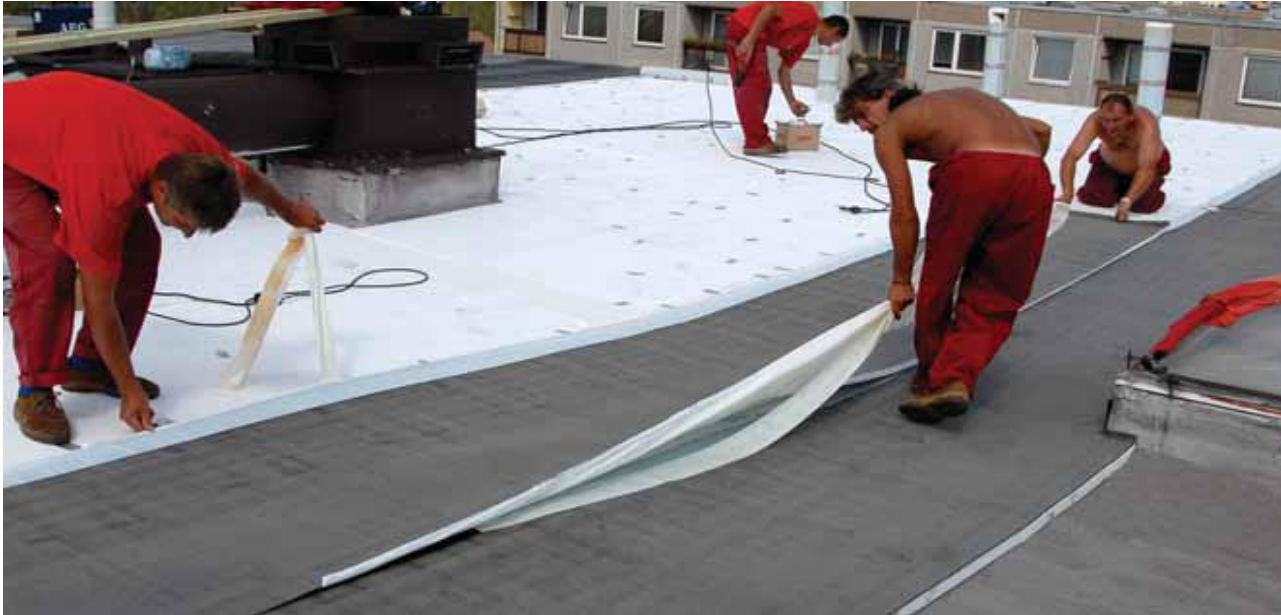
NALEPENÍ SAMOLEPICÍHO HYDROIZOLAČNÍHO ASFALTOVÉHO PÁSU NA STABILIZOVANOU TEPELNOU IZOLACI
