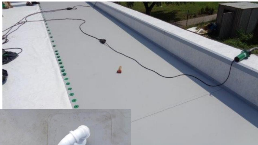
FÓLIE Z PVC PODLOŽENÁ VODIVOU VRSTVOU PRO LOKALIZACI NETĚSNOSTI
