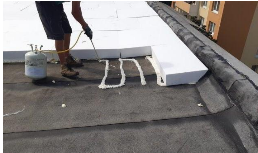
LEPENÍ TEPELNÉ IZOLACE
