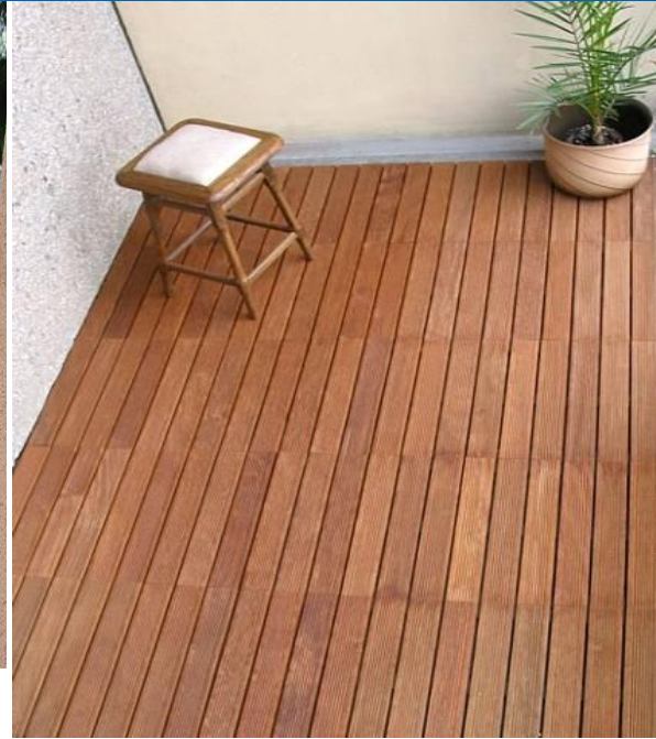
ROŠT Z LAMEL NA REKTIFIKAČNÍCH PODLOŽKÁCH
