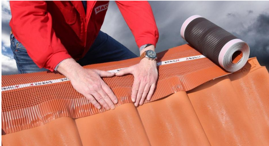
HŘEBENOVÝ PÁS + ŘADA VĚTRACÍCH TAŠEK POD NÍM
