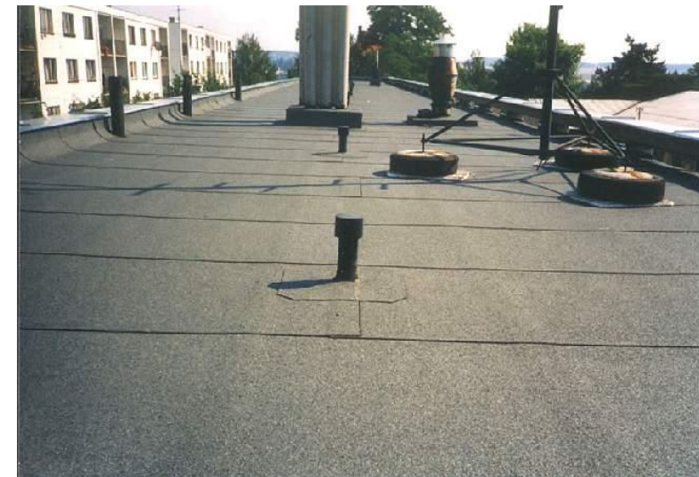
ASFALTOVÉ PÁSY - VÍCE VRSTEV MEZI SEBOU SVAŘENÝCH - PŘEKRÝVAJÍ SE PLOCHY PÁSŮ JEDNÉ VRSTVY SE SPOJÍ SPONÍ VRSTVY
