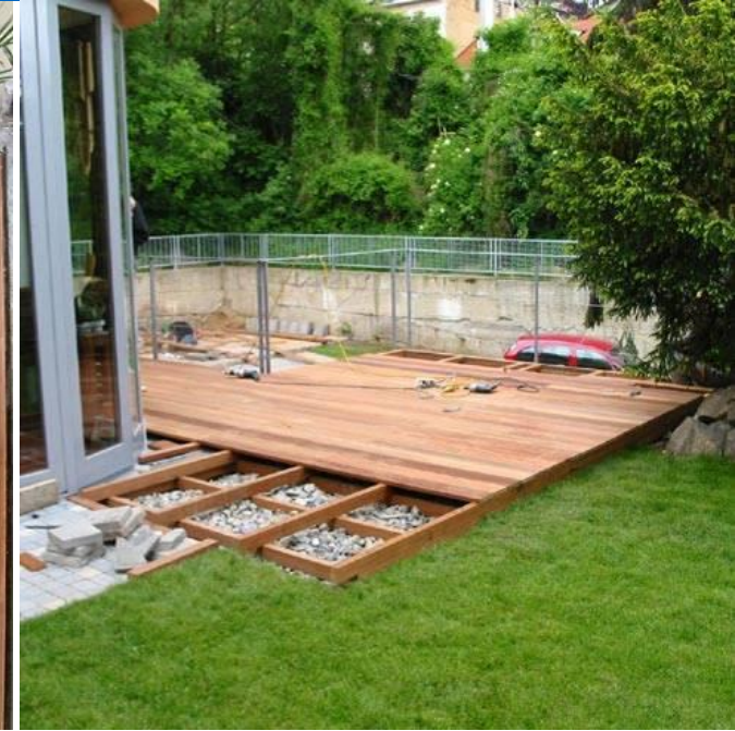
ROŠT Z LAMEL NA REKTIFIKAČNÍCH PODLOŽKÁCH
