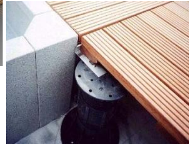
ROŠT Z LAMEL NA REKTIFIKAČNÍCH PODLOŽKÁCH
