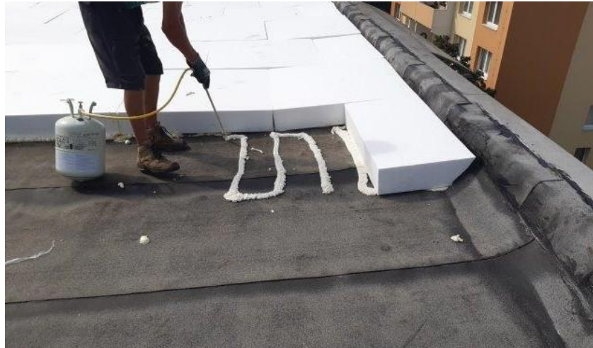
LEPENÍ TEPELNÉ IZOLACE
