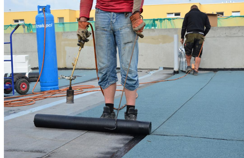
NATAVENÍ VRCHNÍHO HYDROIZOLAČNÍHO ASFALTOVÉHO PÁSU, TEPEM SE FINÁLNĚ AKTIVUJE SPODNÍ SAMOLEPICÍ PÁS
