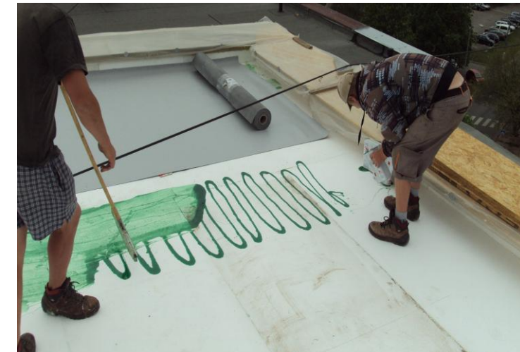
NALEPENÍ HYDROIZOLAČNÍ FOLIE
