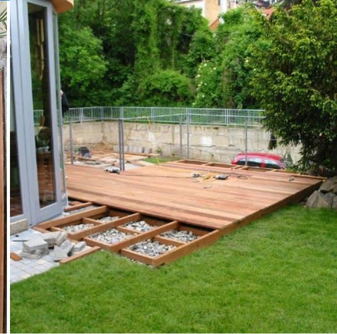
ROŠT Z LAMEL NA REKTIFIKAČNÍCH PODLOŽKÁCH
