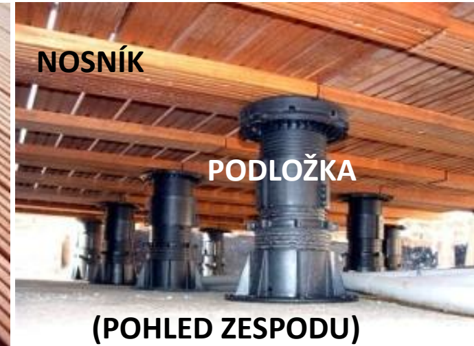
ROŠT Z LAMEL NA REKTIFIKAČNÍCH PODLOŽKÁCH
