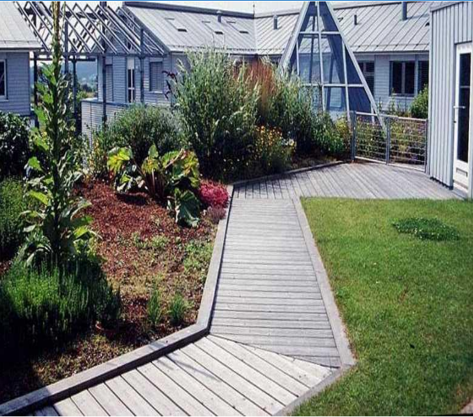
DŘEVĚNÁ „DLAŽDICE“ SMONTOVANÁ S PODLOŽKOU
