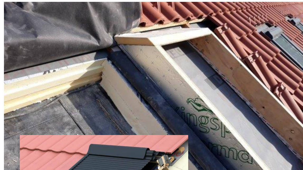
VYMĚŘUJE SE POLOHA, ZABUDOVÁN BUDE VE VRSTVĚ PIR
