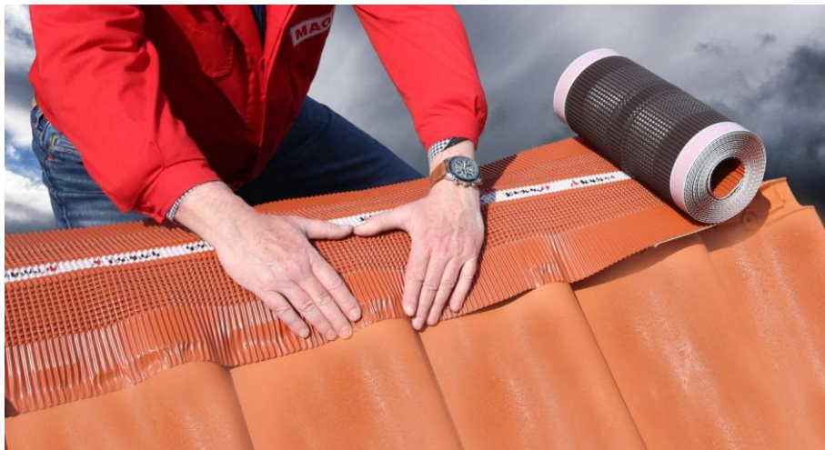
HŘEBENOVÝ PÁS + ŘADA VĚTRACÍCH TAŠEK POD NÍM
