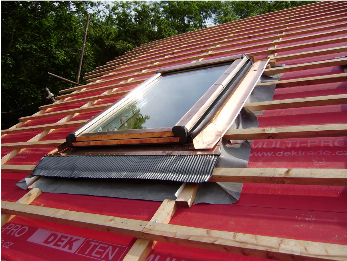
SPECIÁLNÍ FÓLIE (NOSNÁ TEXTILIE SE ZÁTĚREM – PU, PA)
