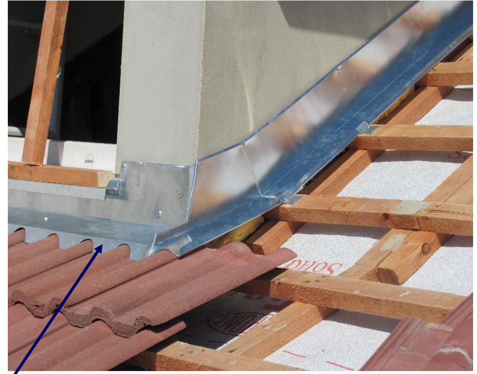
SPODNÍ LEMOVÁNÍ JE VYTVAROVANÉ PODLE TVARU VLN TAŠEK
