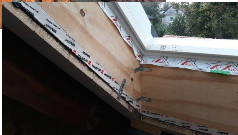
SPOLEHLIVĚJŠÍ ZAJIŠTĚNÍ VZDUCHOTĚSNOSTI
