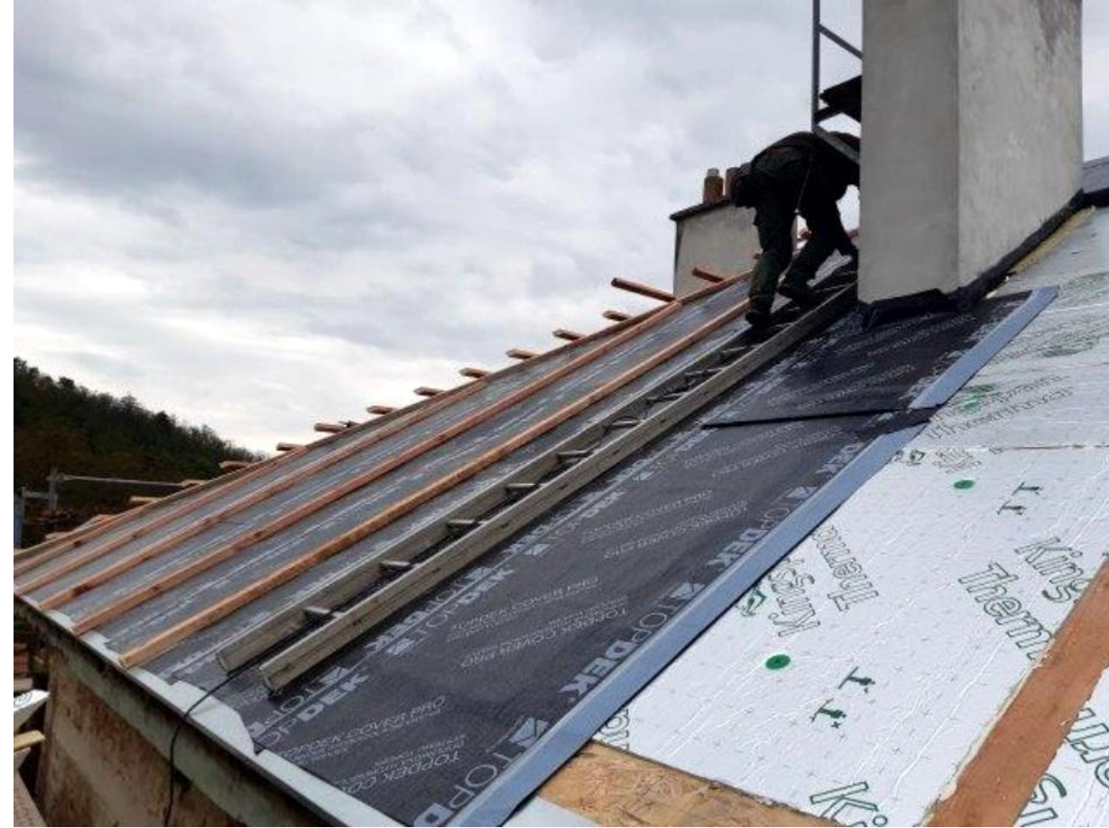
TENKÝ MODIFIKOVANÝ SAMOLEPICÍ ASFALTOVÝ PÁS – JEN NĚKTERÉ SKLADBY
