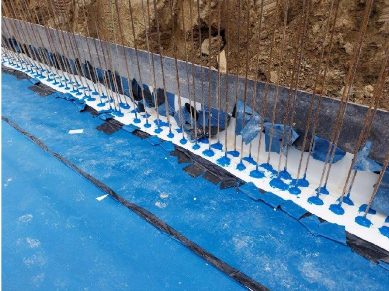
POVLAK Z FÓLIE SPOLUPŮSOBÍCÍ S BÍLOU VANOU (CHEMICKÉ SPOJENÍ AKTIVOVANÉ ALKALICKÝM PROSTŘEDÍM)
