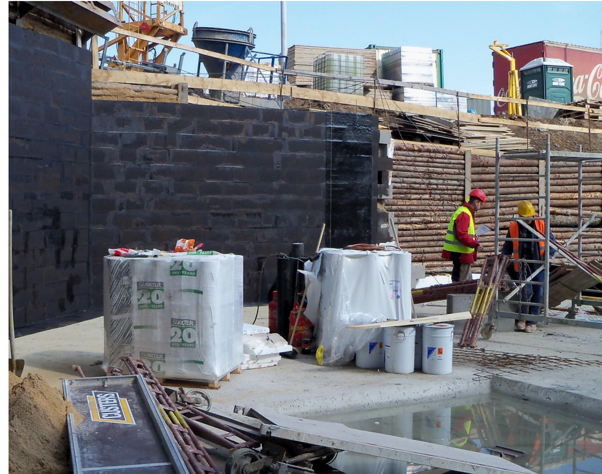
PODKLADNÍ STĚNA PRO HYDROIZOLACI
