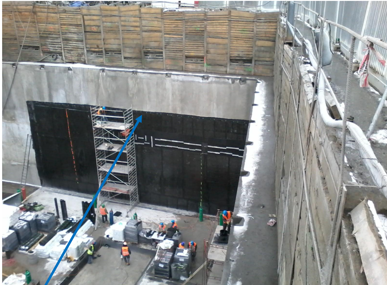
PODKLADNÍ STĚNA PRO HYDROIZOLACI
