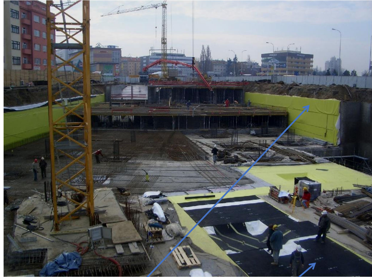
MONTÁŽ OCHRANY PROTI VIBRACÍM Z RECYKLOVANÉ PRYŽE SPOLU S PVC FÓLIÍ
