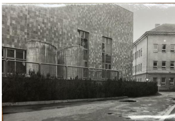
Detail betonových skulptur pro vzduchotechniku, foto: Státní okresní archiv Mělník
