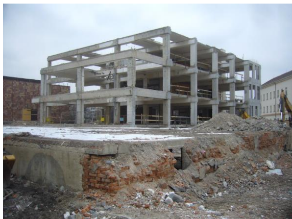
Zmenšený původní železobetonový montovaný skelet během stavby, z webu ceskacenaarchitekturu.cz
