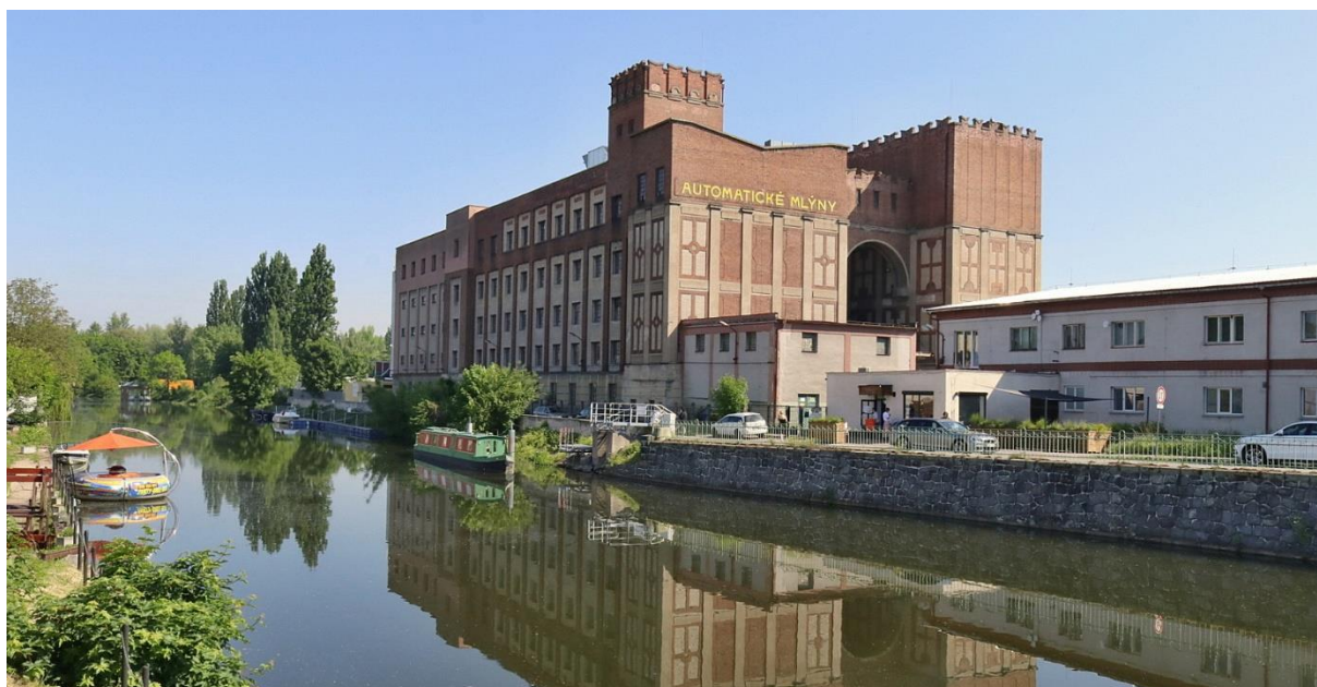
Obrázek 7 – Automatické mlýny před rekonstrukcí
