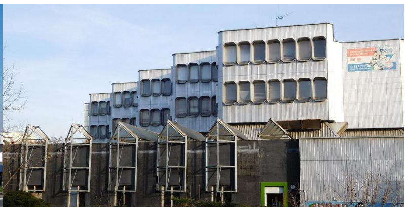
Obr. 13: fasáda telefonní ústředny
