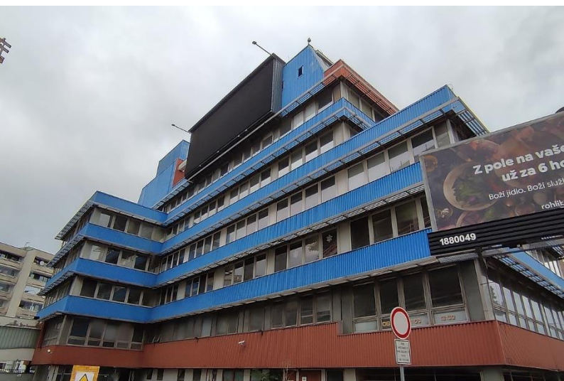
Obr. 11: slunolamy na Poště Praha 120
