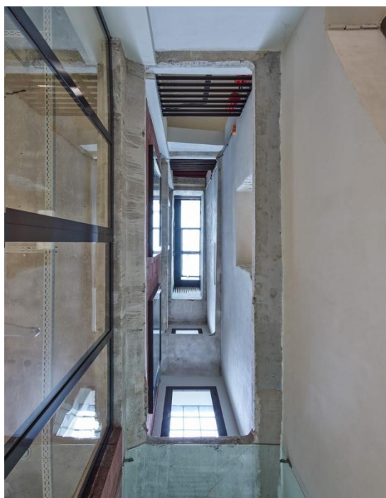
Obrázek11, Nově probouraný světlík na šířku půl modulu, zdroj: https://jecmen.com/cs/projekt/telegraph
