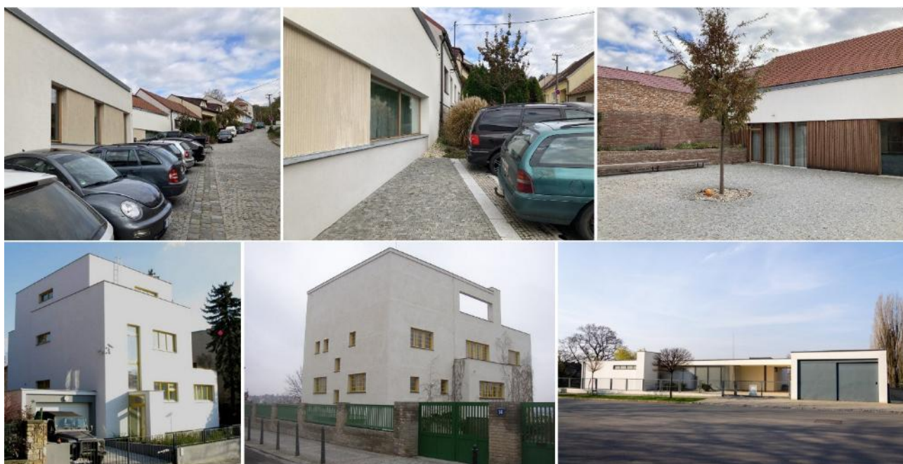
obr. 21 Porovnání architektury komunitního centra a meziválečné architektury
