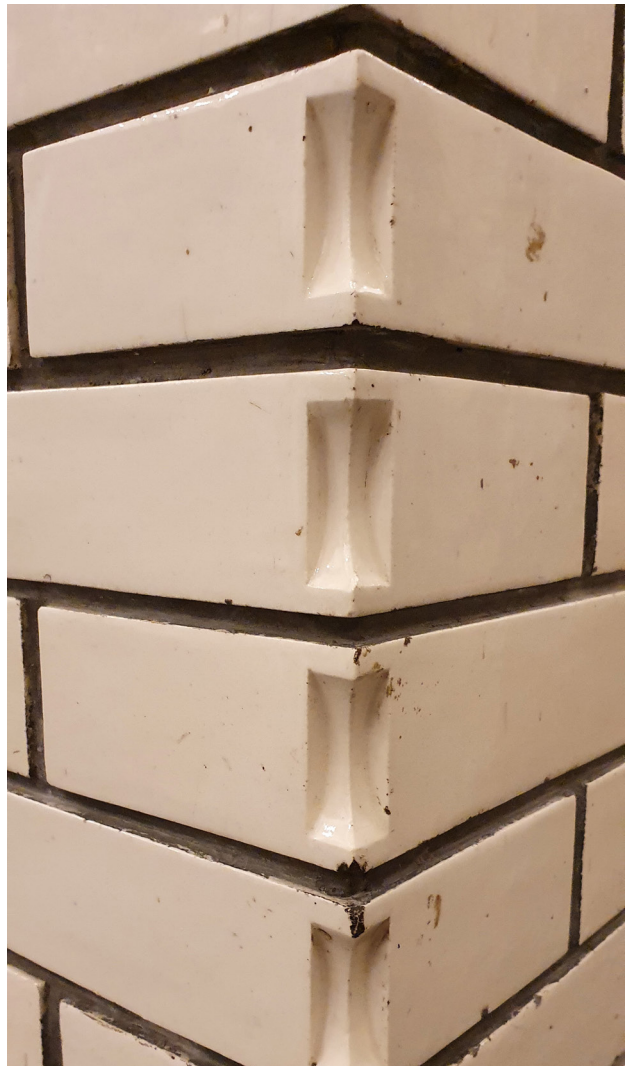
Detail bílých glazovaných cihel v nároží (vlastní tvorba)
