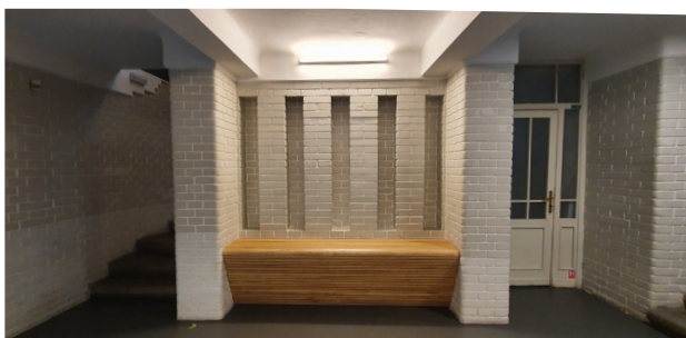
Pohled na krytí radiátorů (vlastní tvorba)
