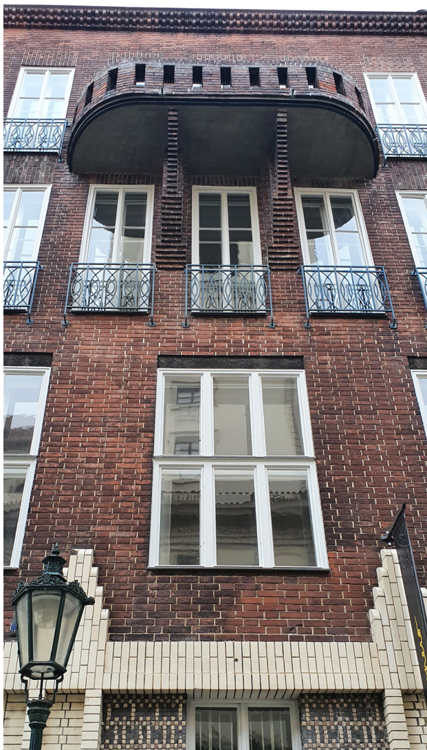
Pohled na balkon a zábradlí v uliční fasádě (vlastní tvorba)
