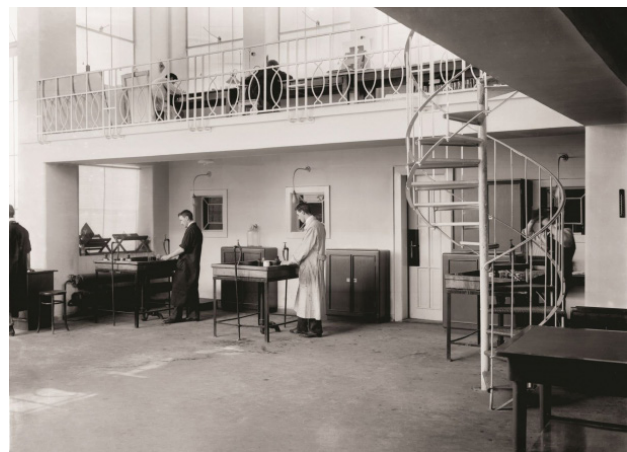
Pohled na ocelové schodiště ( https://www.insidecor.cz/blog/opero-co-working-v-byvalych-grafickych-dilnach )
