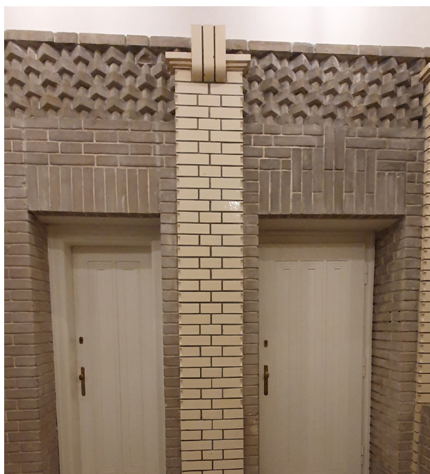
Detail vazby cihel v části nadpraží (vlastní tvorba)
