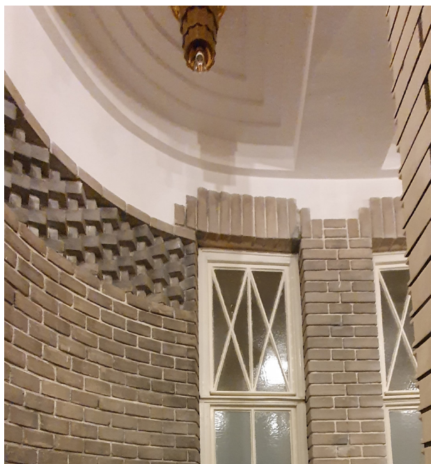
Detail vazby cihel v oblém rohu (vlastní tvorba)
