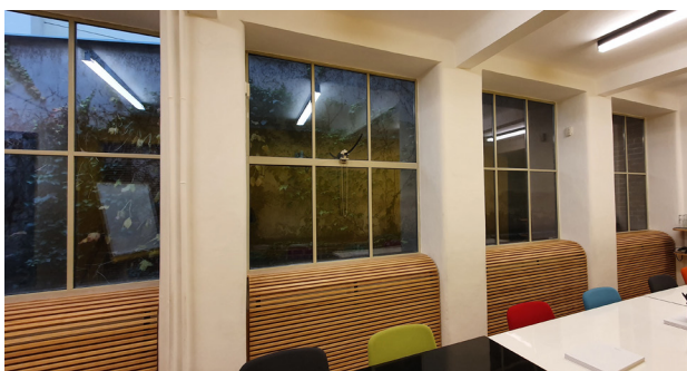
Krytí radiátorů v zasedacích místnostech (vlastní tvorba)
