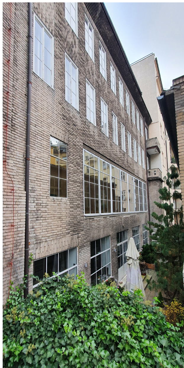
Okna v průmyslové části objektu (vlastní tvorba)
