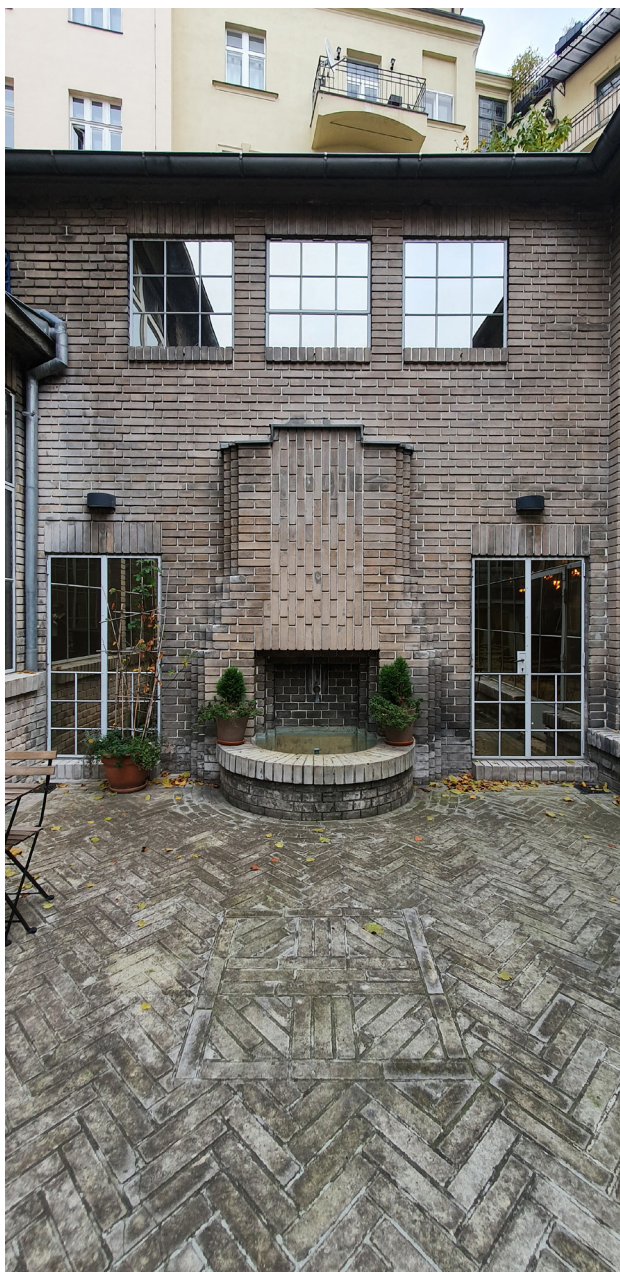
Dlažba pokládaná způsobem rybiny (vlastní tvorba)
