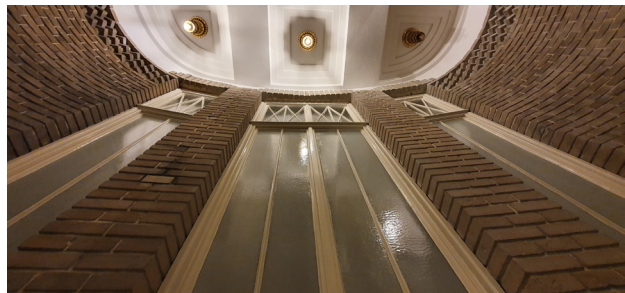
Pohled na strop ze schodiště (vlastní tvorba)
