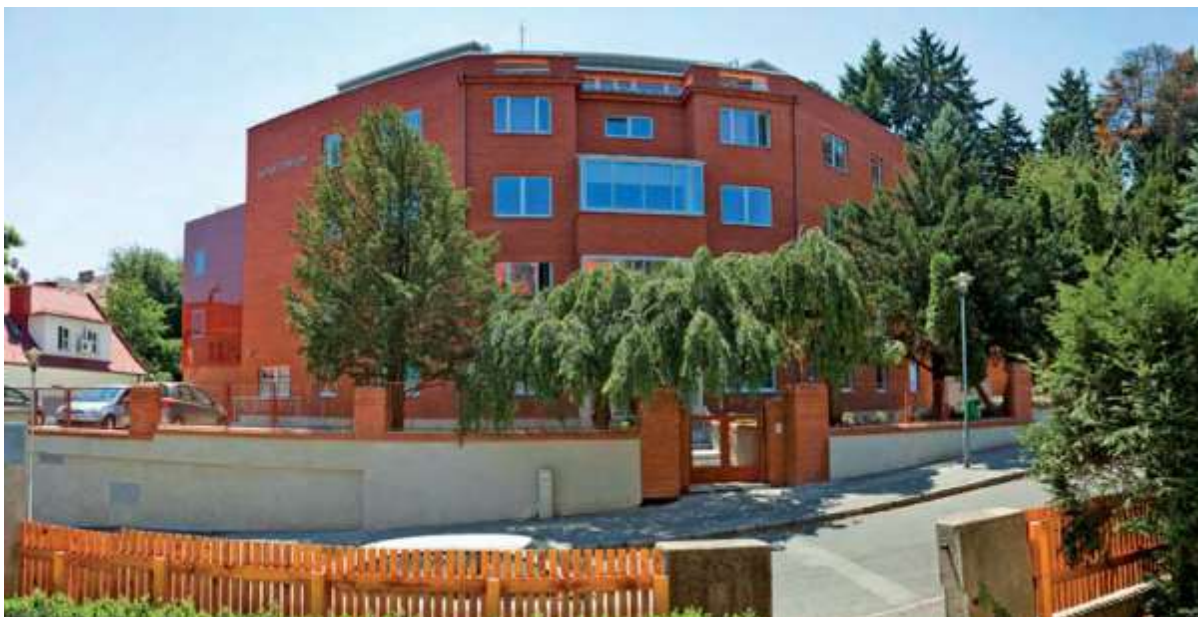
[obr. 5] Kochovo sanatorium po rekonstrukci, in: Ivan Gürtler, Znovu ožilo... Rekonštrukcia Kochovno sanatória v Bratislavě, in: Eurostav , č. 10, 2011, s. 33 - 37
