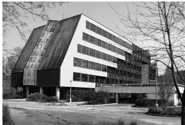
Administrativní budova, Slušovice (foto Michal Kurz, 2019)
