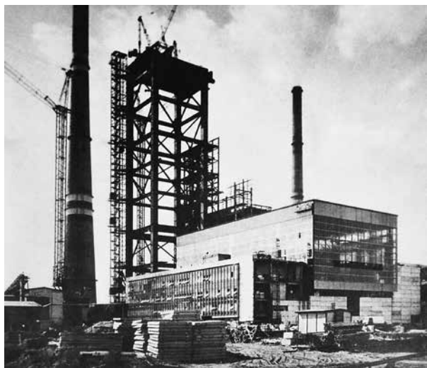
Elektrárna Mělník III, Horní Počaply – výstavba (Elektrárna Mělník, Praha, nedatováno, nestránkováno)
