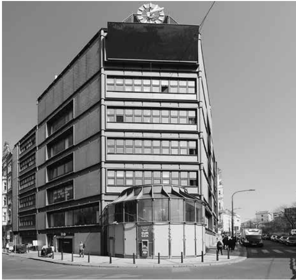
Provozně technická budova DP Metro, Praha (foto Petr Vorlík, 2019)
