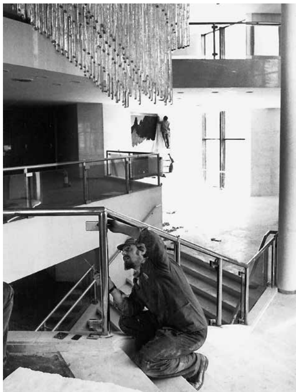
Divadlo pracujících, Most – dokončování interiérů (archiv Městské divadlo v Mostě)
