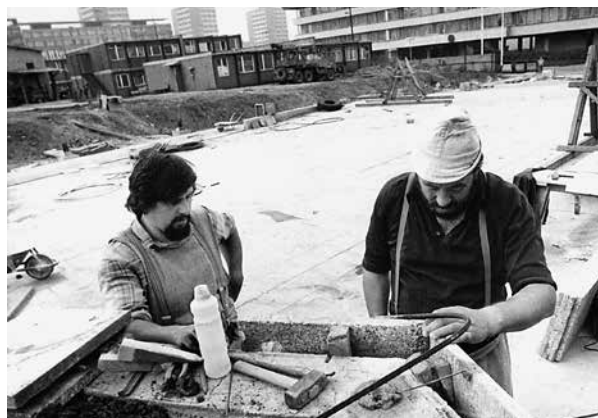
Divadlo pracujících, Most – dokončování kamenných obkladů (archiv Městské divadlo v Mostě)
