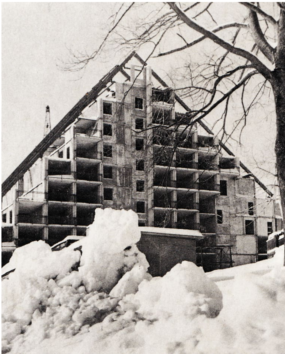
Stavba zotavovny ROH Pochodeň ve Špindlerově Mlýně Construction site of Pochodeň Mountain Resort in Špindlerův Mlýn Karel Schmied, 1978–1983
