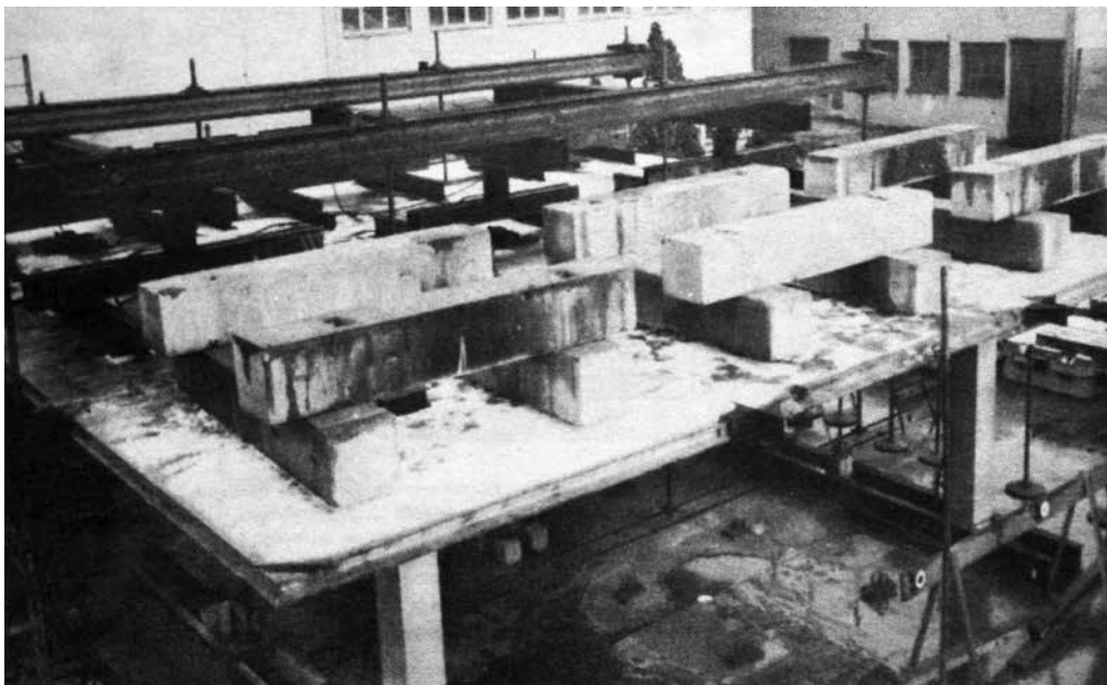
Sloupový systém s deskovou stropní konstrukcí - experimentální zatěžování ve Veselí nad Lužnicí ( Pozemní stavby , 1984, č. 11, s. 487)
