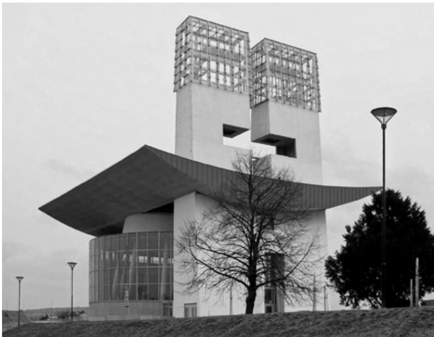
Kostel Svatého Ducha – vstupní fasáda • foto Kamila Matoušková
