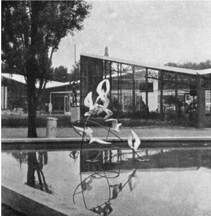
Návštěvnícké prosklené pavilóny v severní části Strahova 1960 • repro Otakar Nový – Jiří Šetlík, Čubr, Hrubý, Pokorný, Praha 1962, neustránkováno.
