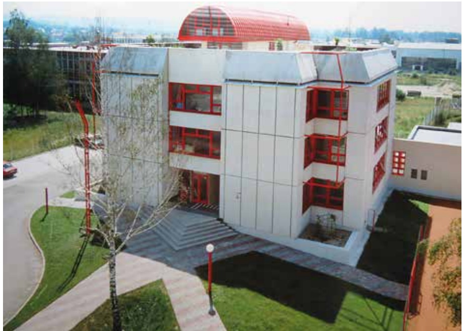
Provozně technická budova Pragoprojektu, České Budějovice, 1986–1988 (soukromý archiv Petra Keila)
