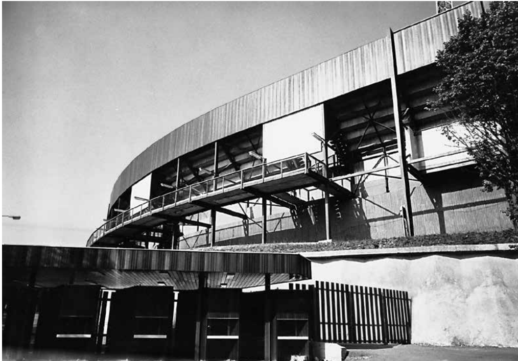
Stadion Evžena Rošického na Strahově, Praha-Břevnov, 1975–1978 (soukromý archiv Petra Kutnara)
