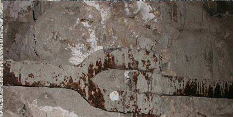
Kované prvky konstrukční: táhla, kleštiny, spojky a čepy
