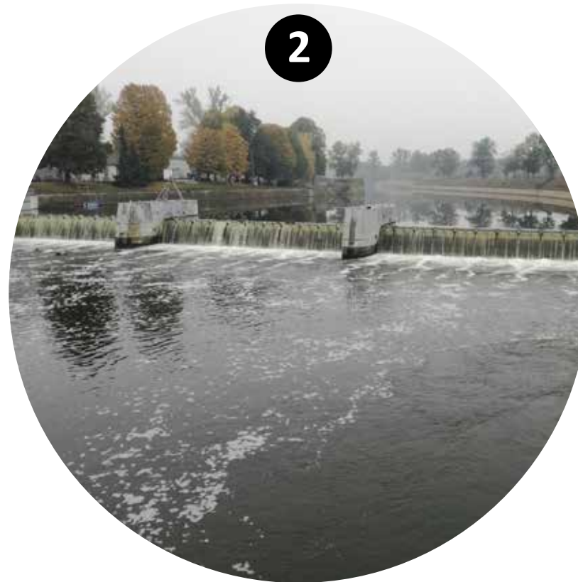
hodnotná vodní stavba - jez s rybím přechodem
