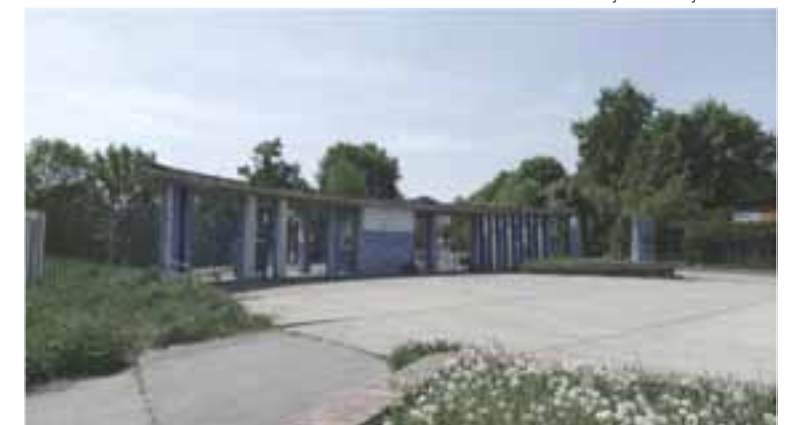
vstup do areálu
