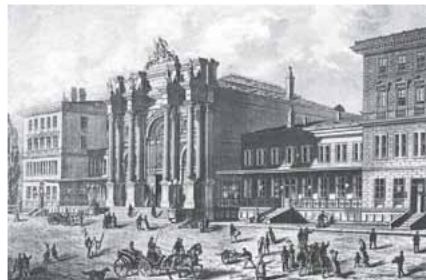
neorenesanční budova nádraží
