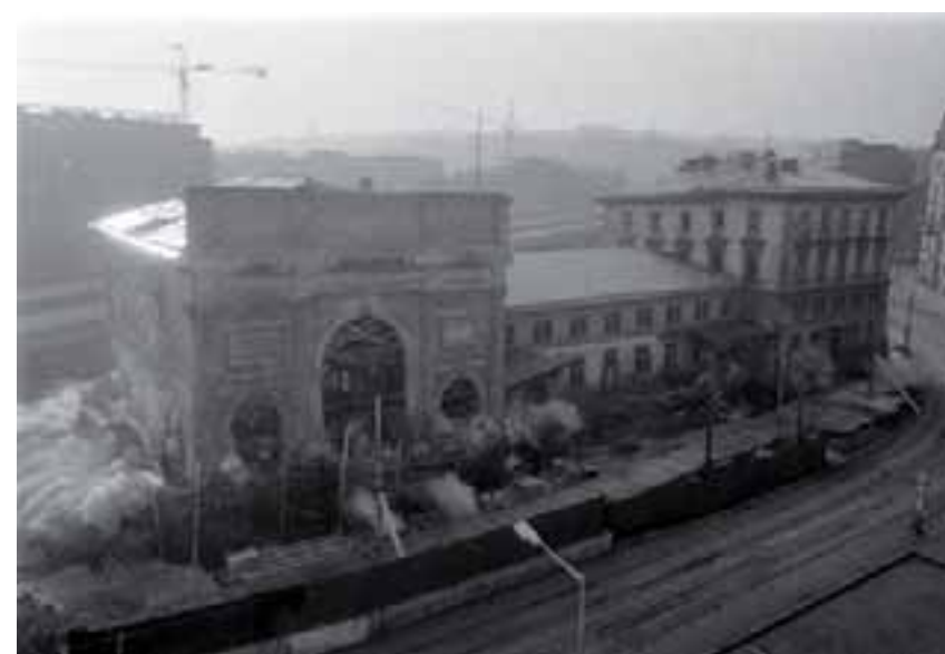
odstřel nádražní budovy
