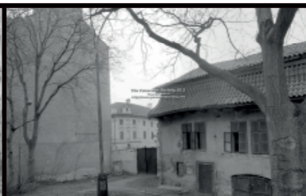
Pohled na řešenou proluku mezi štítem domu a stájemi
