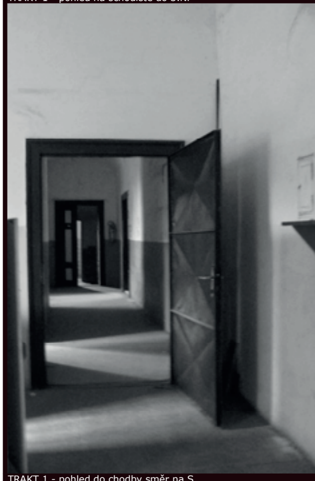
TRAKT 1 - pohled do chodby směr na S
