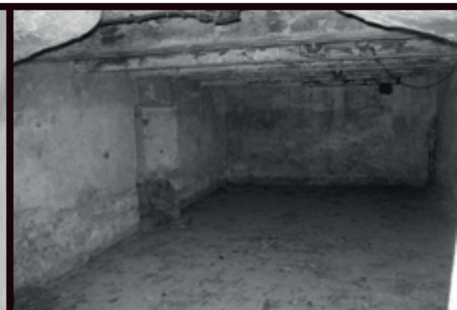
TRAKT 3 - pohled do místnosti 1.patra
