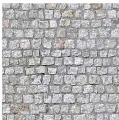
Chodník z kamených dlažebních kostek.
