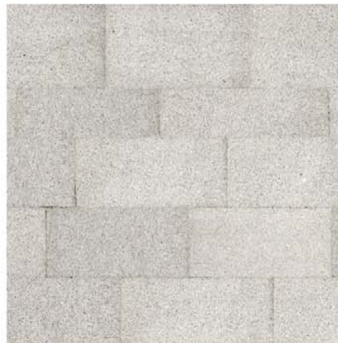
Kamenný obklad fasády žulovými deskami s provětrávanou mezerou.
