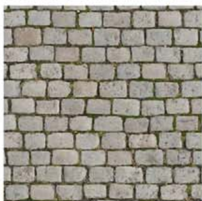
Kamená dlažba vozovky v ulice Krymská.
