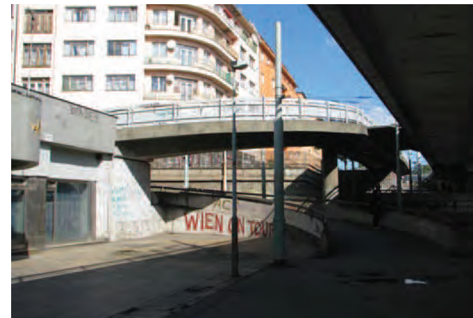
Mimoúrovňové křížení tramvaje a Bubenské ulice
