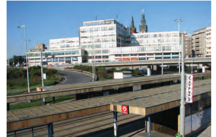
Mimoúrovňové vedení Bubenské ulice před budovou býv. El. podniků
