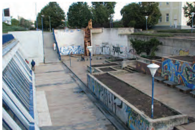
Zchátralý veřejný prostor u stanice metra
