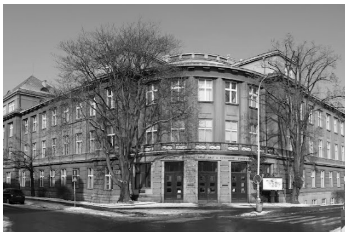
VYSOKÁ ŠKOLA ZEMĚDĚLSKÉHO A LESNÍHO INŽENÝRSTVÍ S FAKULTOU ARCHITEKTURY A POZEMNÍHO STAVITELSTVÍ A S KLOKNEROVÝM ÚSTAVEM (Theodor Petřík, Antonín Engel, 1925 - 1937)
