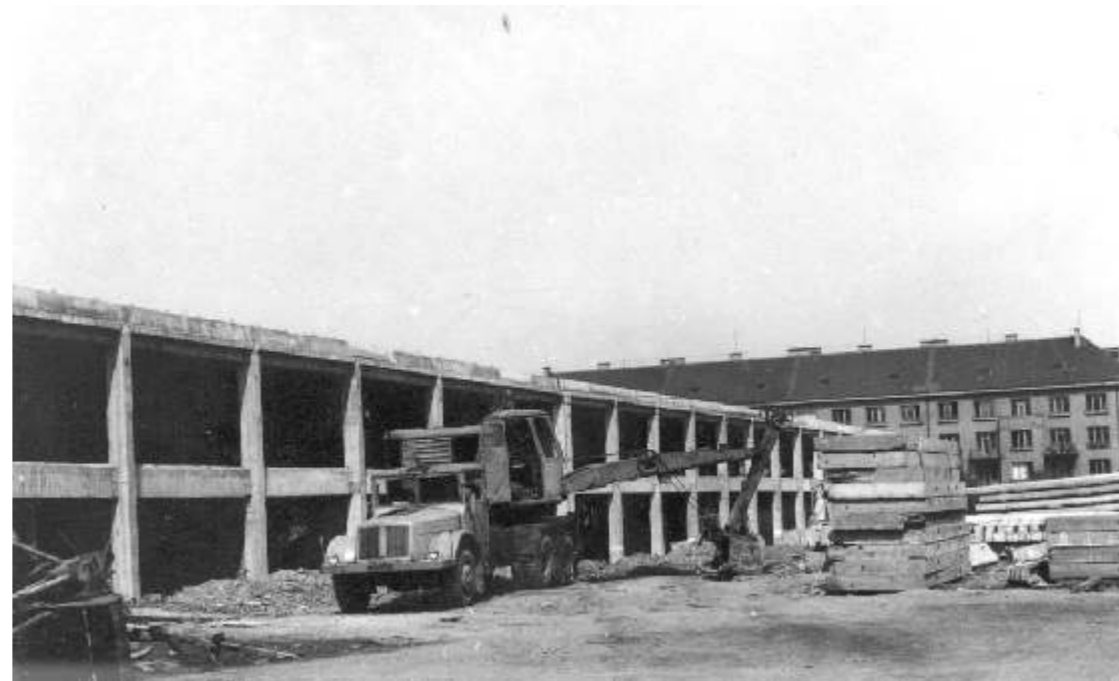
VÝSTAVBA HALOVÝCH LABORATOŘÍ, 1965 - 1968
