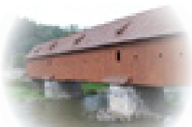
DŘEVĚNÝ MOST V RADOŠOVĚ
