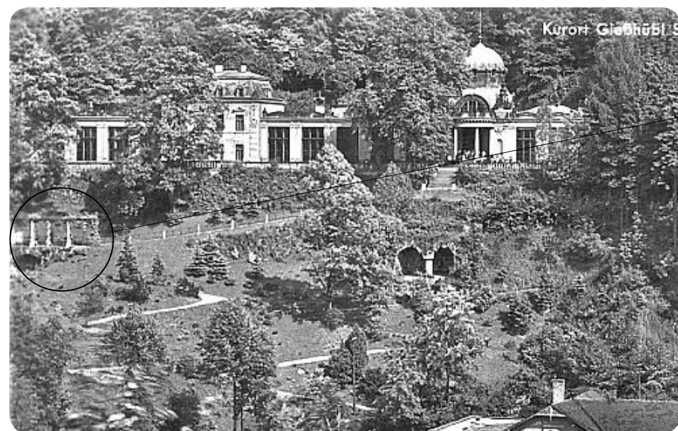
20-30-léta 20.století (po přestavbě budovy restaurace)
