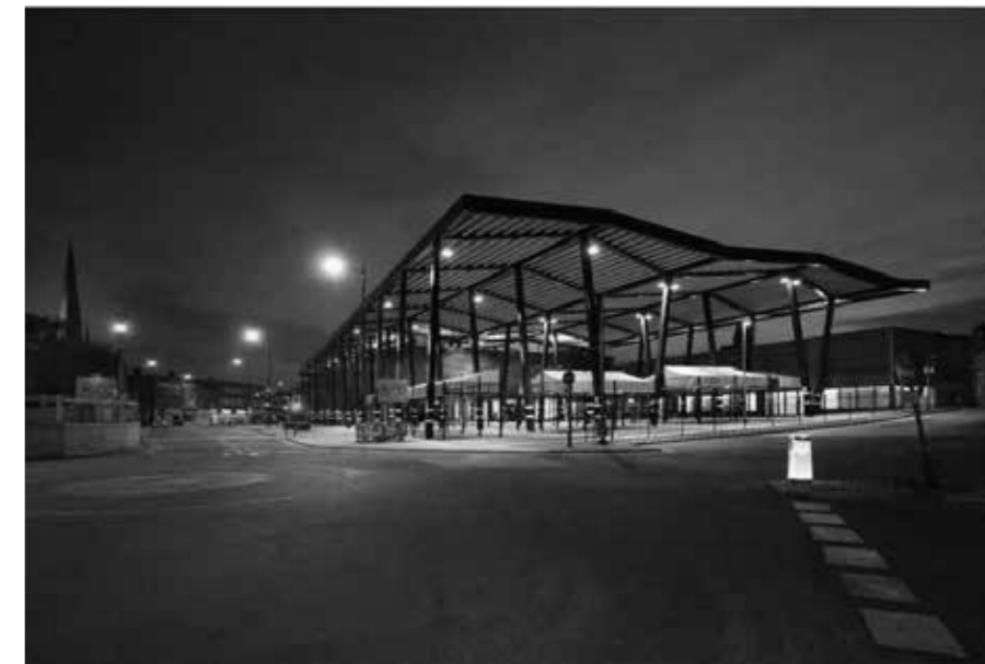
Dnes tržnici chápeme jako zastřešený veřejný prostor pro prodej potravin.
