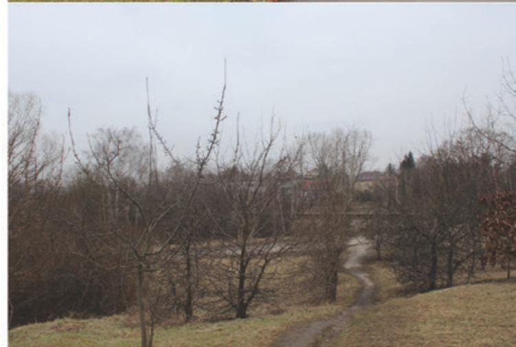
DUN (dešťová usazovací nádrž) a přilehlý pozemek
