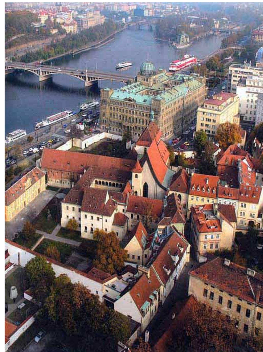
Ptačí perspektiva s pozadím Štefánikova mostu, budovy ministerstva průmyslu a obchodu
