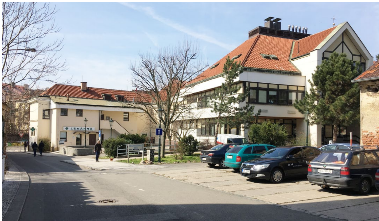
Pohled z ulice Horská. Hlavní vstup do Revmatologického ústav se nachází na pravé straně pod vystupujícím rizalitem.
