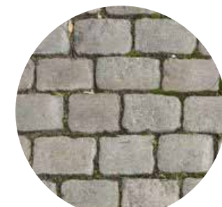
žulová vozovková dlažba 16/14cm páteřní komunikace
