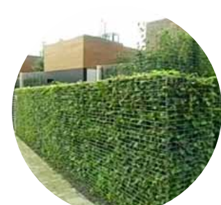
oplocení předzahrádek - gabion se zelení, výška 750mm
