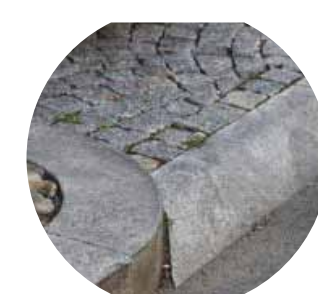
sklopený obrubník vymezující parkovací stání
