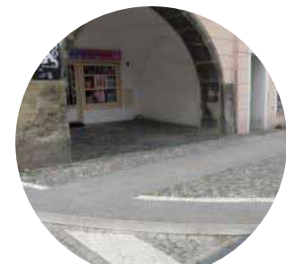
signální a varovný pás z kamenné dlažby
