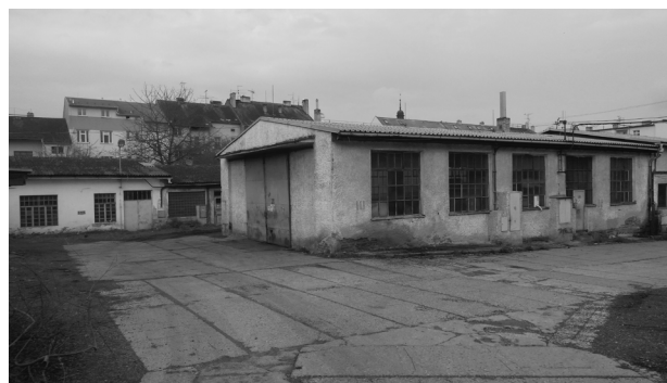
D budovy vnitrobloku určené k demolici
