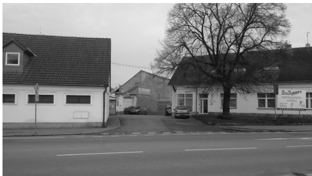
A úzký vstup do bloku s atypickým pláckem
