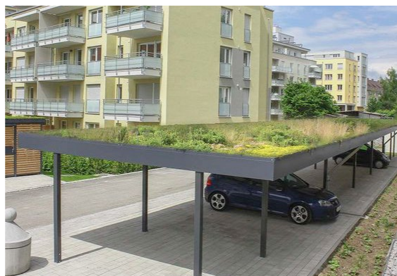
030 Přístřešek se zelenou střechou. [neznámé]
