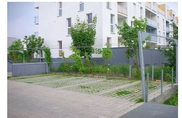
028 Stání ve vnitrobloku s materiálovým odlišením. [Belgie, Boussu, Quartier de la Haute Borne]
