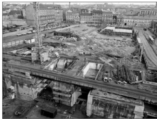
▲ Stavba linky metra B, Na Knížecí
