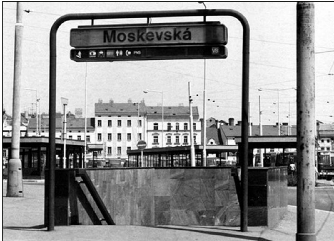
▲ Dokončený vstup metra z ulice Stroupežnického
