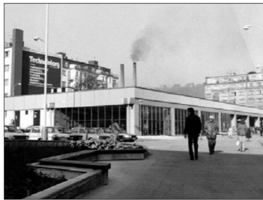
▲ Bývalý vstup stanice metra Anděl
