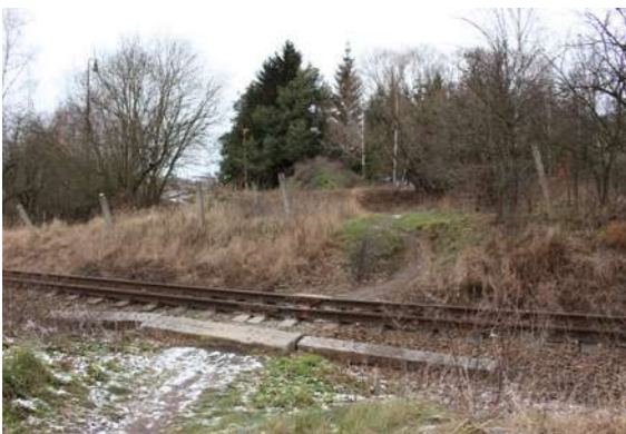
09 Pěší přechod přes železniční trať
