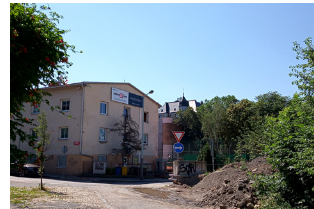
roh ulice Kunětické a Španělské
