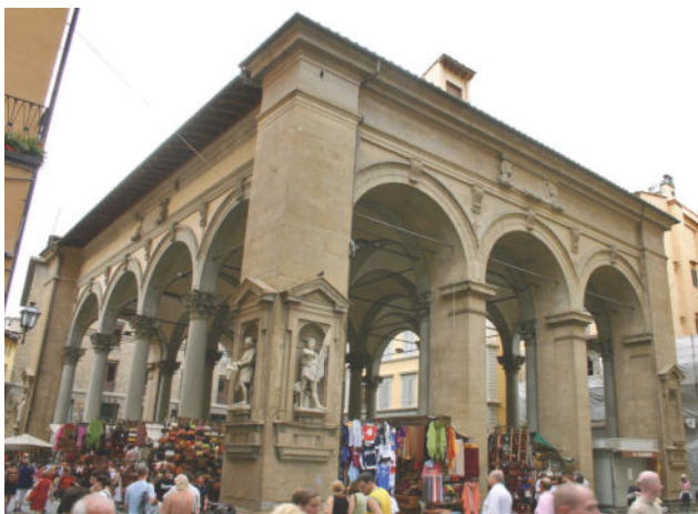
exteriér loggia del mercato, florencia
