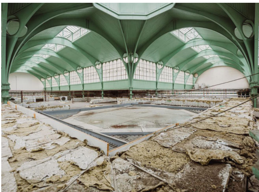
interiér haly s litinovými vazníky a dřevěným bedněním nad vestavěným pohledem
