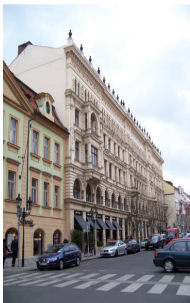
průčelí uličního domu z Rytířské
