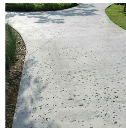
Betonová cesta je páteřní komunikací. Propojuje vstupy do parku.
