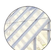
Bílá ocelová konstrukce
