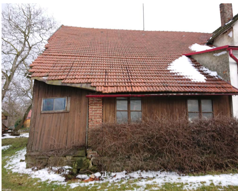
Přistavěná dílna k hlavnímu objektu
