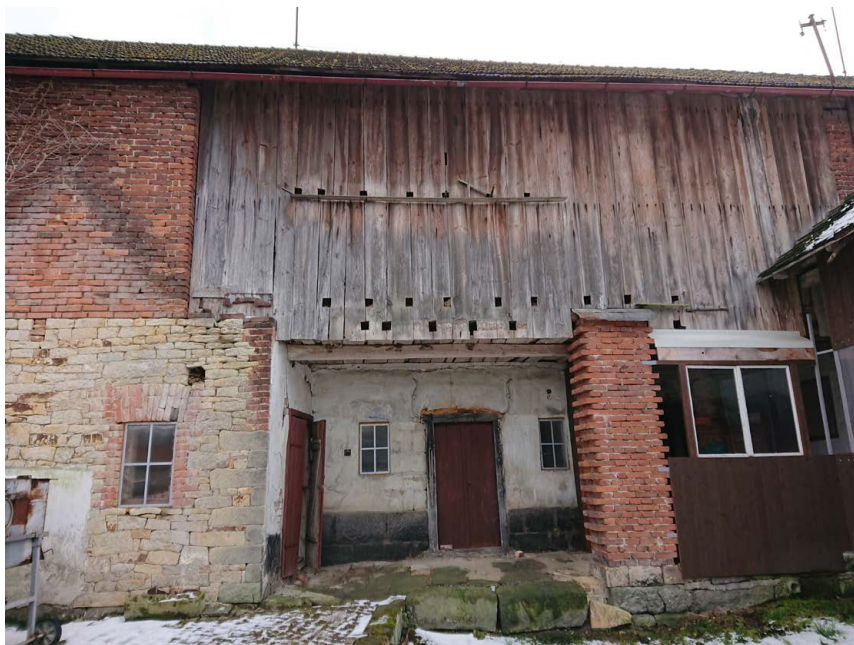
Dřevěná stěna seníku při pohledu ze dvora s bývalým holubníkem (díry ve stěně).
