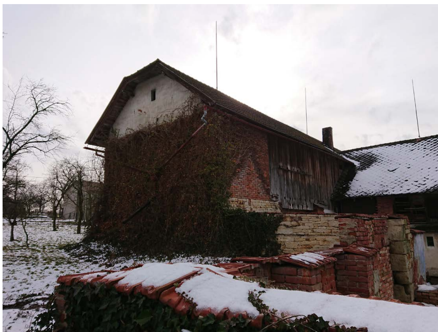
Východní křídlo budovy.
