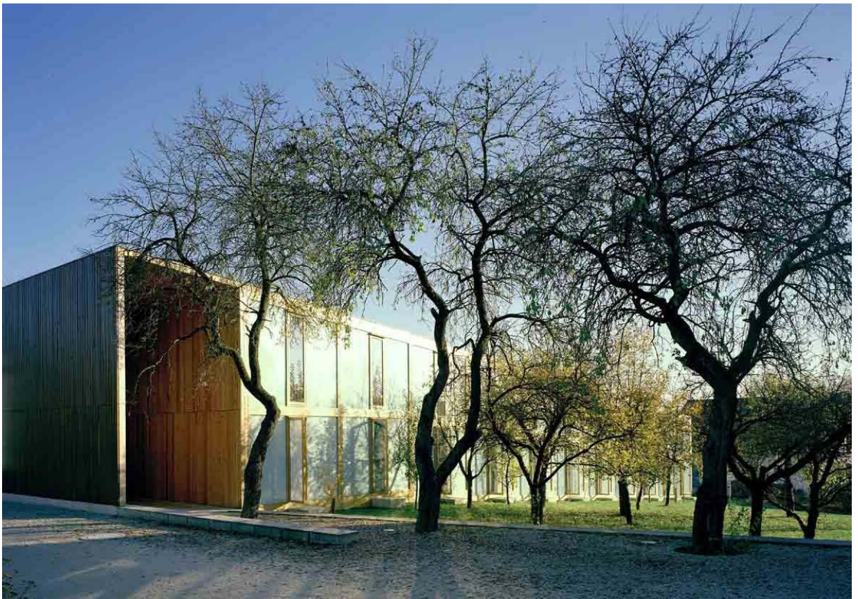
Deppisch Architekten: Biohotel in the Apple Orchard. Kranzberg - Německo. Jeden z příkladů realizace staveb v jablňovém sadě.
