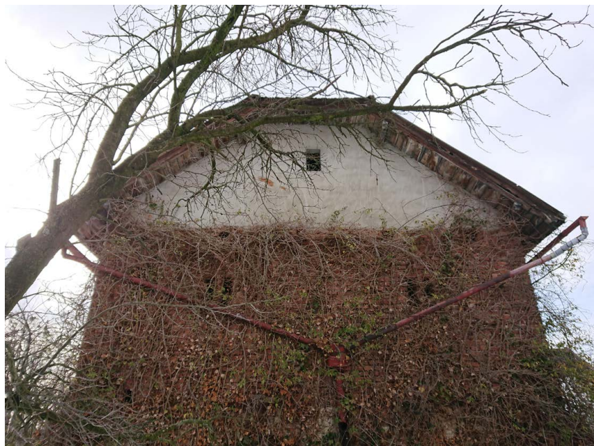
Východní stěna zemědělské části.
