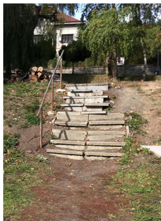
- kamenné schodiště v pravém boku školy jsou v havarijním vztavu - 15 schodů
