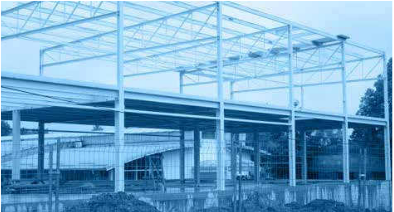
Příhradový nosník v projektu plánují uplatnit společně s prostorovou příhradovou konstrukcí.
