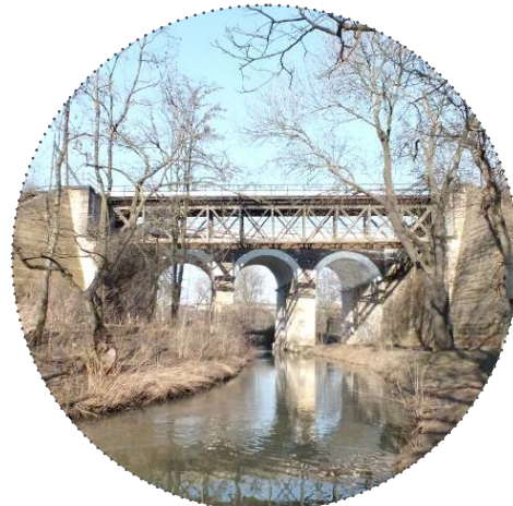
viadukt u Hořejšího rybníka
