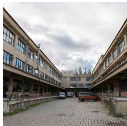
1B Polootevřený vnitroblok mezi křídly objektu „E“
