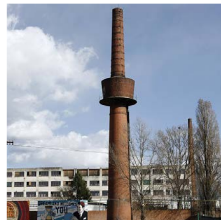
2A Komín s vodojemem
