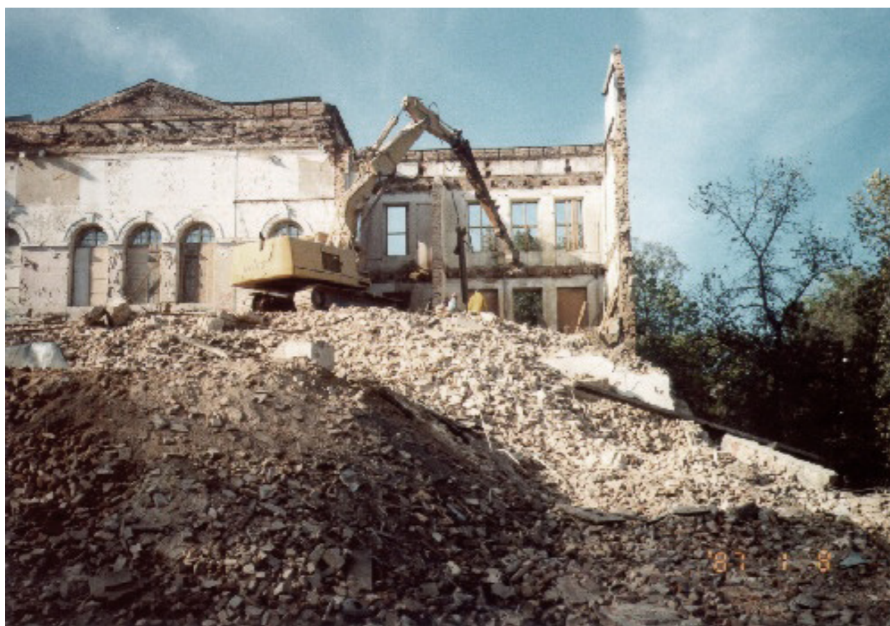
Bourací práce na Rudolfinu
