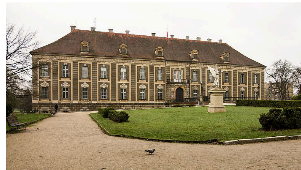
Obr. 94: Zaháňský zámek má od pohledu nákladnější provedení než ten Nosticův v Rokytnici, přesto se o něm šlechtic zmiňuje pouze v rozsahu jednoho řádku.
