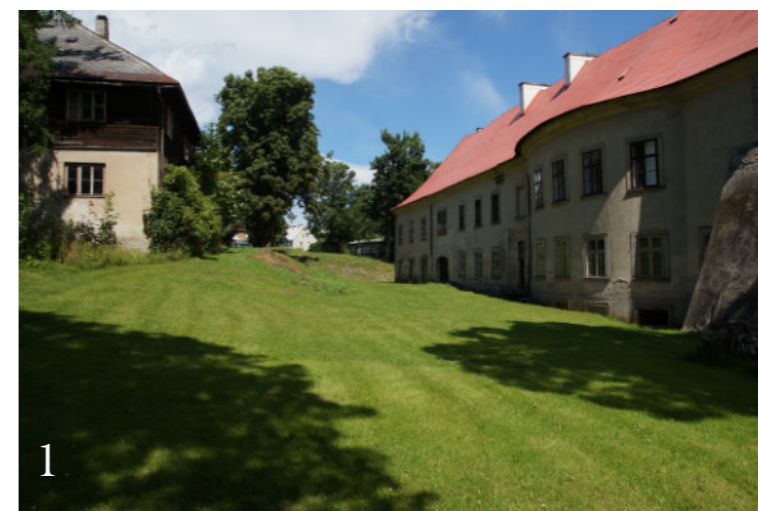
Obr. 25: Pohled na severozápadní stranu zámku a terénní zlom pod dvorem
