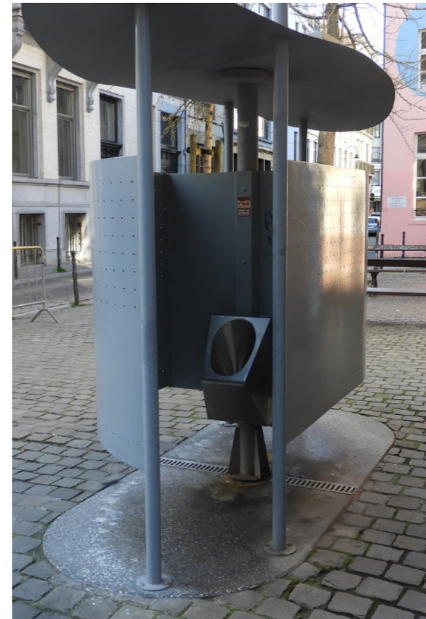
4 bezvodý pisoár v Bruselu
