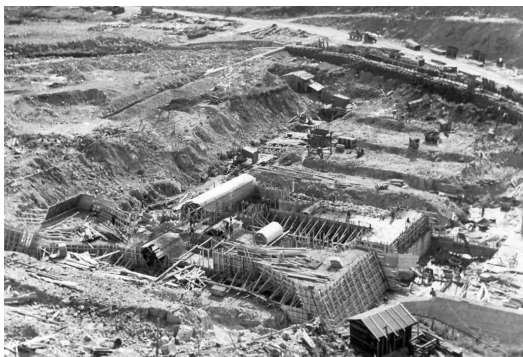
Viditelné tesařské práce na bednění pilířů
