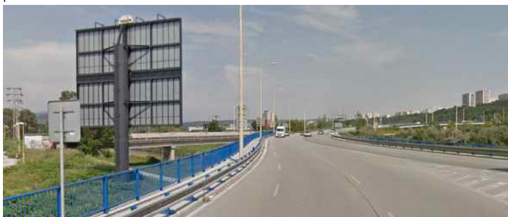
pohľad na zbernú cestu a rieku
