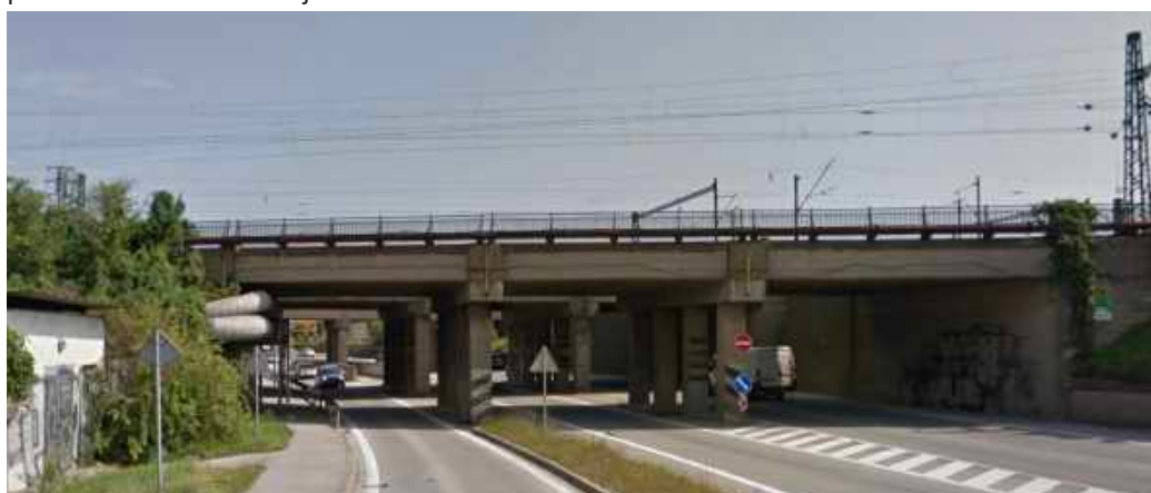
pohľad na železniční nadjazd
