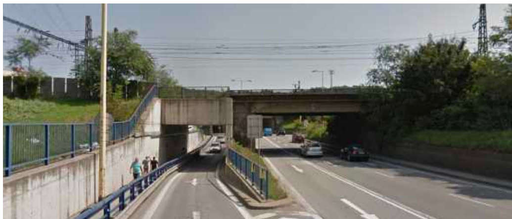
pohľad na železniční nadjazd
