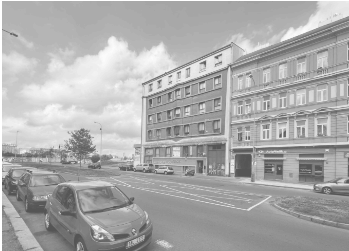
dům č.p.217 (bývalé pekárny) | pohled z ulice Dělnická
