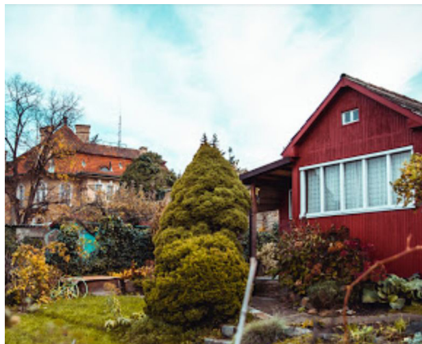
záhradkárská osada na Ořechovce blízkosť záhrad a pamiatkovo chránenej štruktúry (7)
