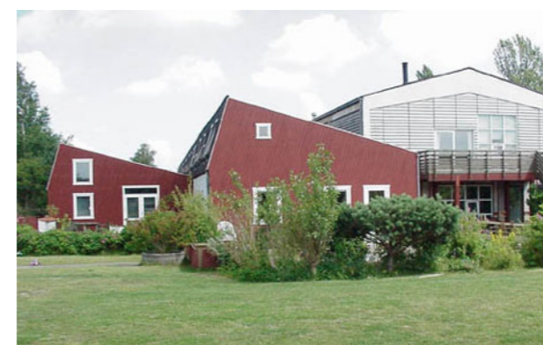
Dánsko, Jernstoberiet, rekonstrukce průmyslového objektu
